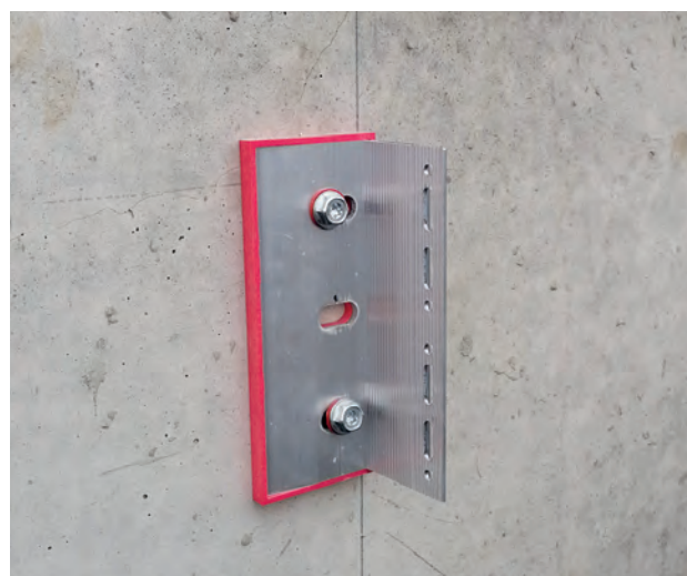
Staffa doppia con placca di compensazione in PVC.
